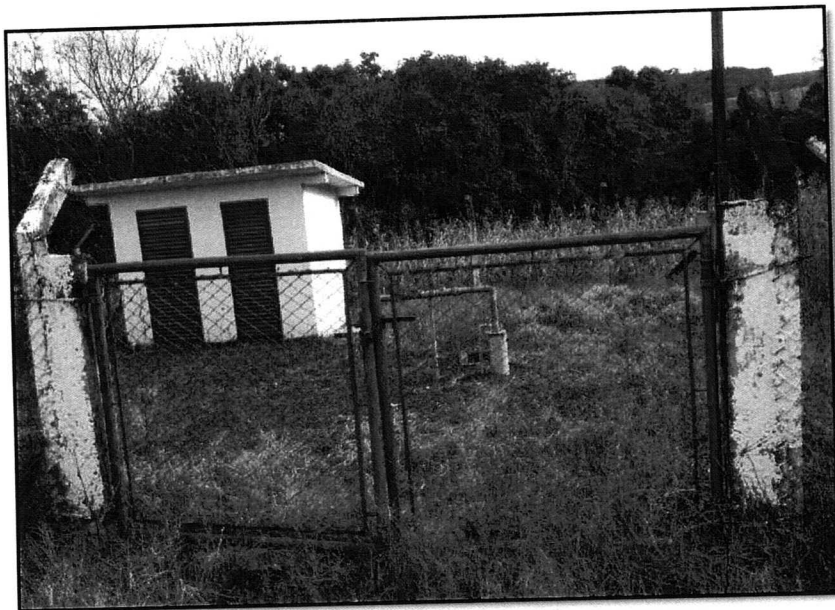
FIGURA 2.164 - SITUAÇÃO DAS INSTALAÇÕES DA CAPTAÇÃO DA COMUNIDADE BARRA BONITA. FONTE: TRABALHO DE CAMPO AMBIENTAL COSTA OESTE. (2014).
