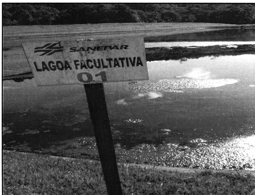
FIGURA 2.224 – LAGOA FACULTATIVA 01 DA ETE PITANGA. FONTE: TRABALHO DE CAMPO, AMBIENTAL COSTA OESTE (2014).
