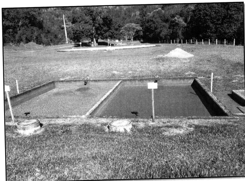
FIGURA 2.229 – LEITO DE SECAGEM DA ETE PITANGA. FONTE: TRABALHO DE CAMPO, AMBIENTAL COSTA OESTE (2014).
