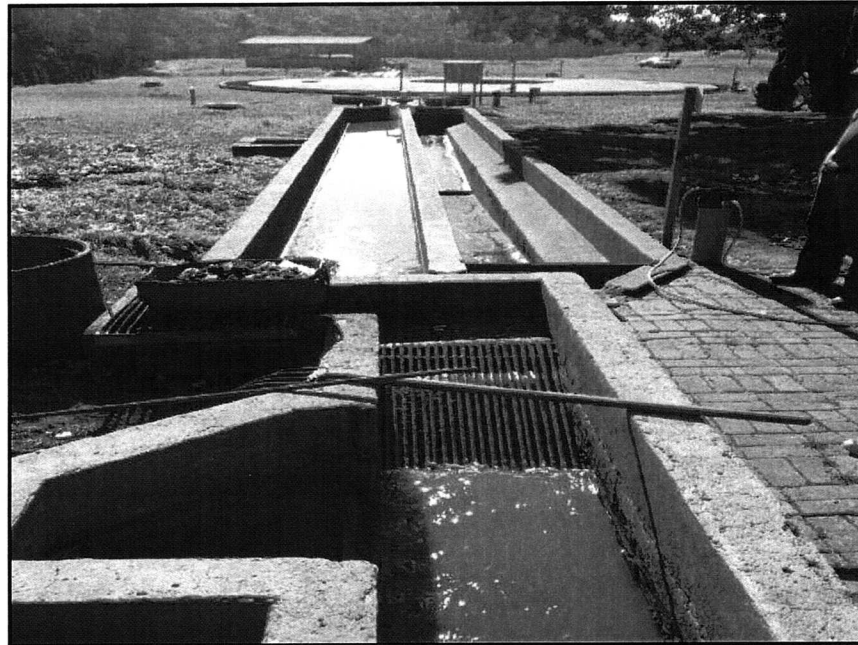
FIGURA 2.217 – GRADEAMENTO PRELIMINAR ETE PITANGA. FONTE: TRABALHO DE CAMPO, AMBIENTAL COSTA OESTE (2014).
