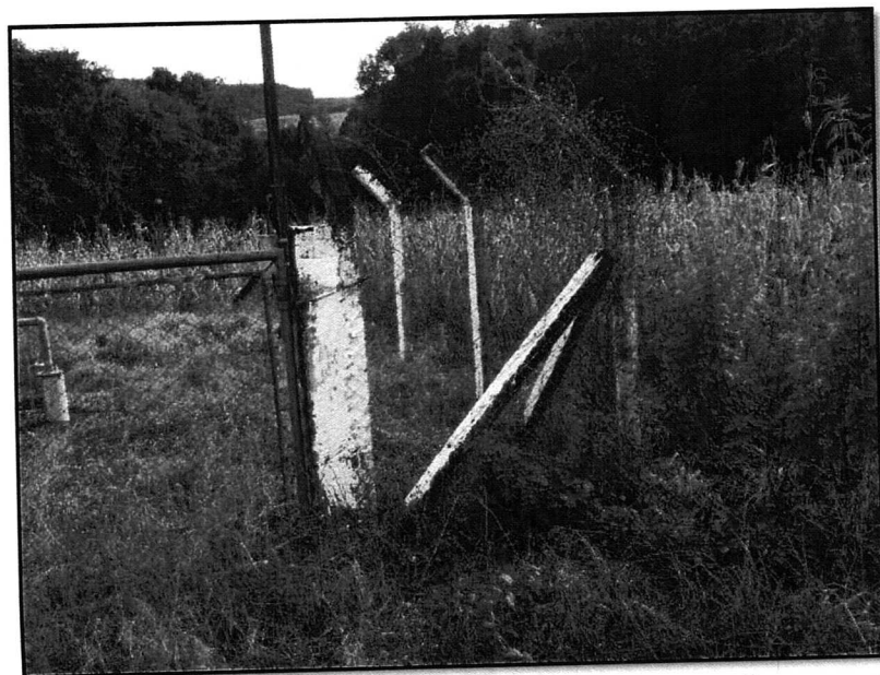
FIGURA 2.165 – SITUAÇÃO DAS INSTALAÇÕES DA CAPTAÇÃO DA COMUNIDADE BARRA BONITA. FONTE: TRABALHO DE CAMPO AMBIENTAL COSTA OESTE. (2014).
