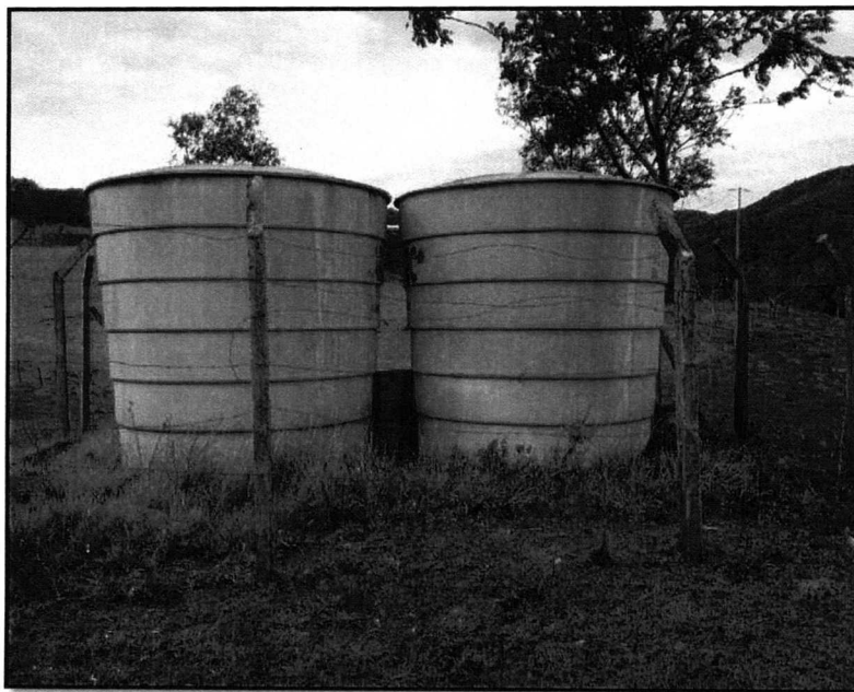
FIGURA 2.172 – RESERVATÓRIOS DA COMUNIDADE BARRA BONITA. FONTE: TRABALHO DE CAMPO AMBIENTAL COSTA OESTE. (2014).
