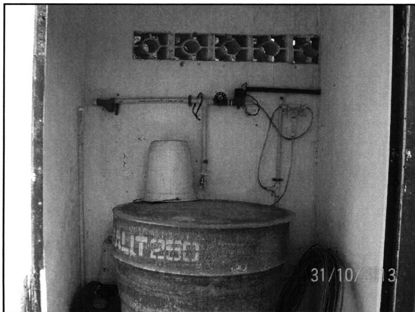
FIGURA 2.169 – CASA DE TRATAMENTO NÃO UTILIZADA NA COMUNIDADE BARRA BONITA.
