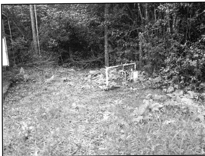
FIGURA 2.209 – ESTRUTURA DO POÇO DA COMUNIDADE XAXIM. FONTE: TRABALHO A CAMPO DA AMBIENTAL COSTA OESTE.
