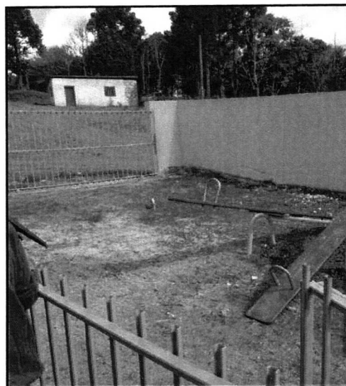
FIGURA 2.183 – SITUAÇÃO PRECÁRIA DAS INSTALAÇÕES DO POÇO NA ESCOLA DA COMUNIDADE RIO DO MEIO.
