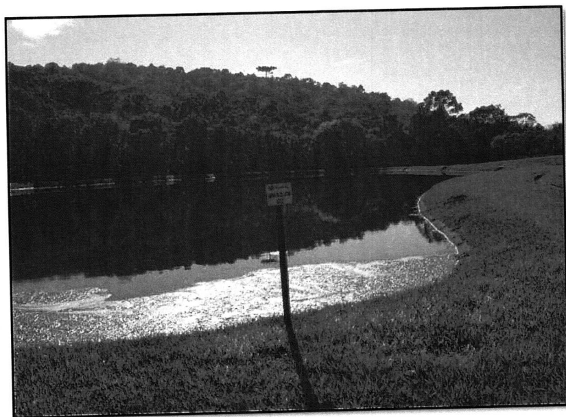
FIGURA 2.226 – LAGOA FACULTATIVA 02 DA ETE PITANGA. FONTE: TRABALHO DE CAMPO, AMBIENTAL COSTA OESTE (2014).
