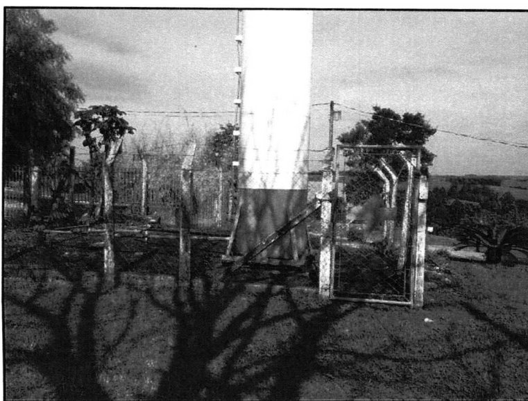
FIGURA 2.159 – RESERVATÓRIO DA COMUNIDADE VILA NOVA DOS ALEMÃES. FONTE: TRABALHO DE CAMPO AMBIENTAL COSTA OESTE. (2014).
