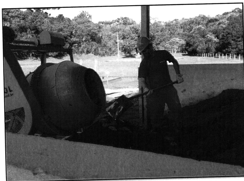
FIGURA 2.230 – PROCESSO DE MISTURA NO LODO DA ETE PITANGA. FONTE: TRABALHO DE CAMPO, AMBIENTAL COSTA OESTE (2014).
