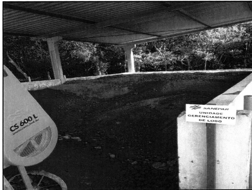
FIGURA 2.231 – LODO PRONTO PARA DOAÇÃO. FONTE: TRABALHO DE CAMPO, AMBIENTAL COSTA OESTE (2014).
