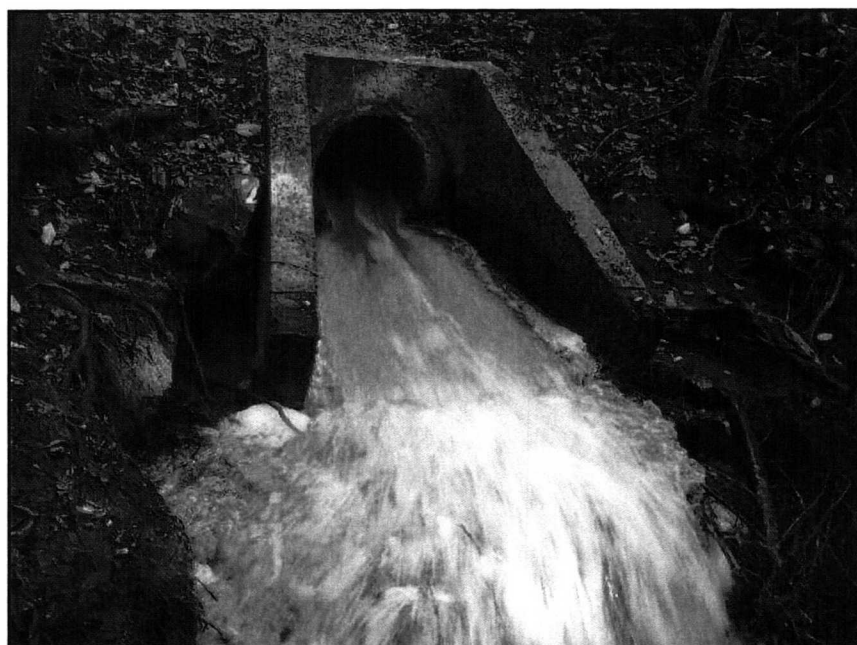
FIGURA 2.233 – PONTO DE LANÇAMENTO DA ETE. FONTE: SANEPAR (2016).
