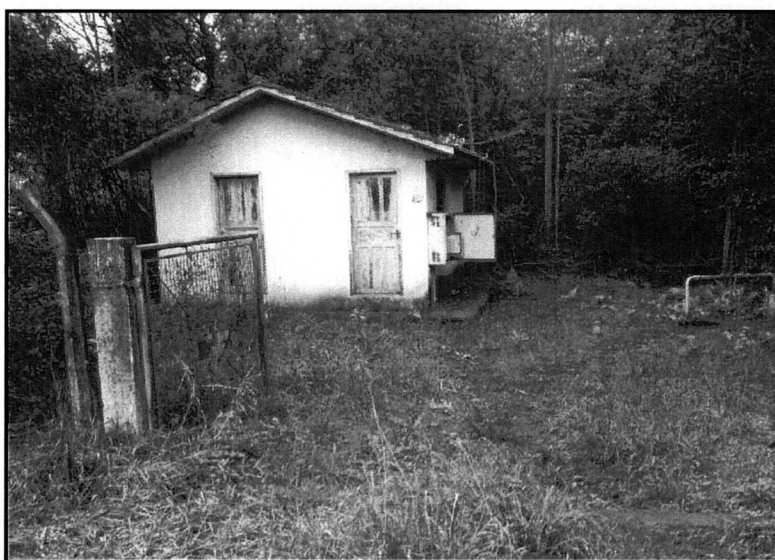
FIGURA 2.207 – ESTRUTURA DO POÇO DA COMUNIDADE XAXIM.
