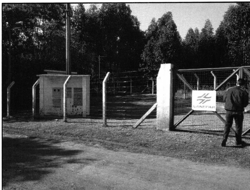
FIGURA 2.115 – ESTRUTURA DA CAPTAÇÃO SUBTERRÂNEA FONTE: TRABALHO DE CAMPO, AMBIENTAL COSTA OESTE (2014).
