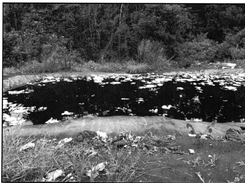
FIGURA 2.62 – LAGOA PARA TRATAMENTO DE CHORUME NO ATERRO SANITÁRIO. FONTE – TRABALHO DE CAMPO AMBIENTAL COSTA OESTE (2014).
