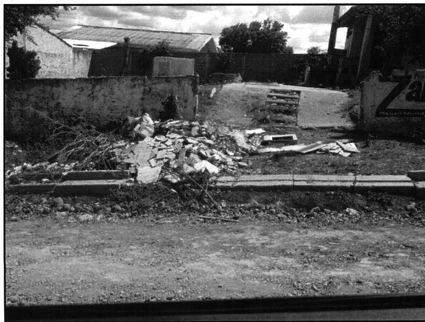
FIGURA 2.83 – ACONDICIONAMENTO DOS RCC DE FORMA ERRADA PELOS MUNICÍPIES. FONTE – TRABALHO DE CAMPO EMPRESA AMBIENTAL COSTA OESTE (2014).
