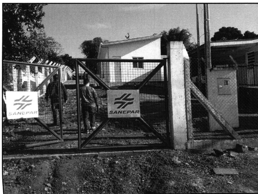
FIGURA 2.133 – RESERVATÓRIO CERCADO E COM PORTÃO PARA EVITAR A ENTRADA DE PESSOAS NÃO AUTORIZADAS.
