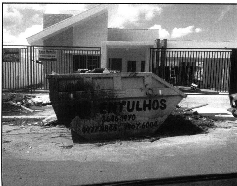
FIGURA 2.81 – ACONDICIONAMENTO DOS RCC, QUANDO SE CONTRATA EMPRESA ESPECIALIZADA. FONTE – TRABALHO DE CAMPO EMPRESA AMBIENTAL COSTA OESTE (2014).
