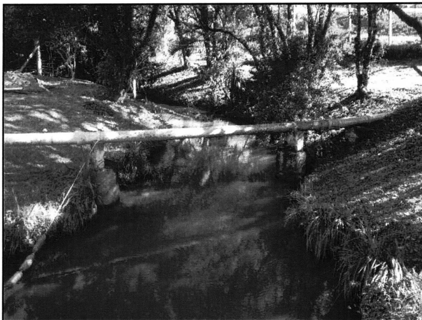
FIGURA 2.110 – SITUAÇÃO ATUAL DO RIO ERNESTO. FONTE: TRABALHO DE CAMPO, AMBIENTAL COSTA OESTE (2014).
