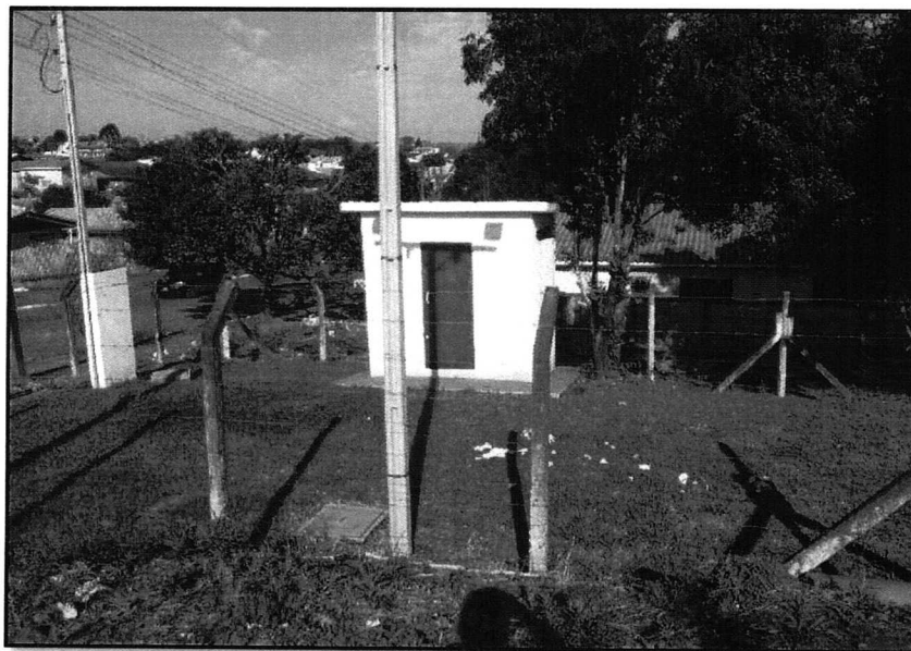
FIGURA 2.145 – ALMOXARIFADO DO LOCAL DA ESTRUTURA DO BOOSTER NO BAIRRO MARISTELA.
