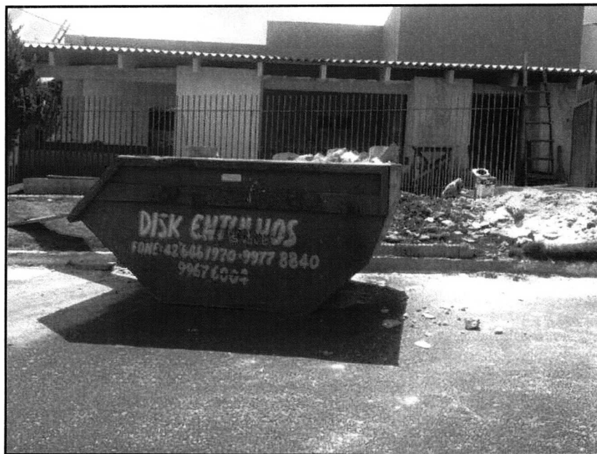
FIGURA 2.80 – ACONDICIONAMENTO DOS RCC, QUANDO SE CONTRATA EMPRESA ESPECIALIZADA. FONTE – TRABALHO DE CAMPO EMPRESA AMBIENTAL COSTA OESTE (2014).
