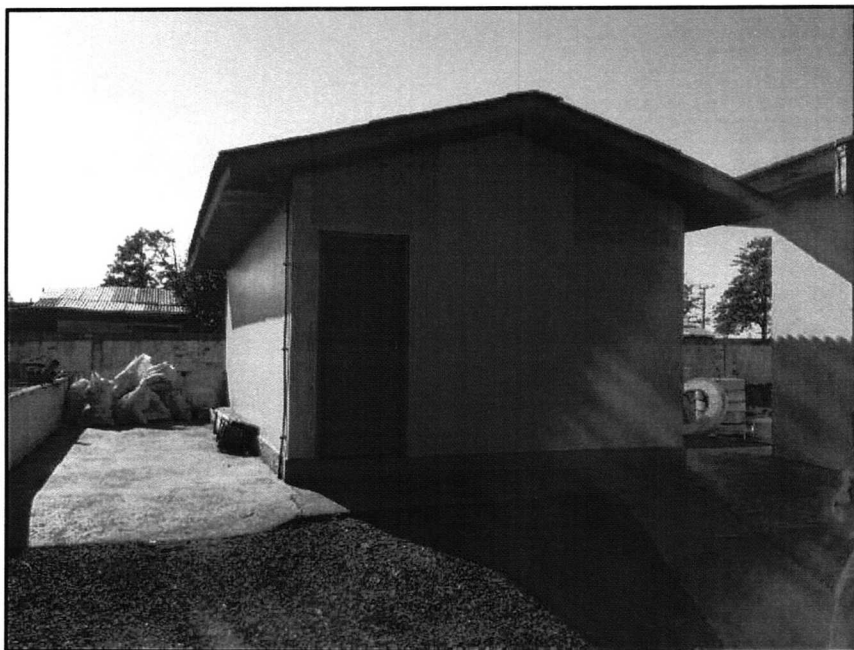
FIGURA 2.130 – ALMOXARIFADO NO RESERVATÓRIO ALTO DA COLINA. FONTE: TRABALHO DE CAMPO, AMBIENTAL COSTA OESTE (2014)
