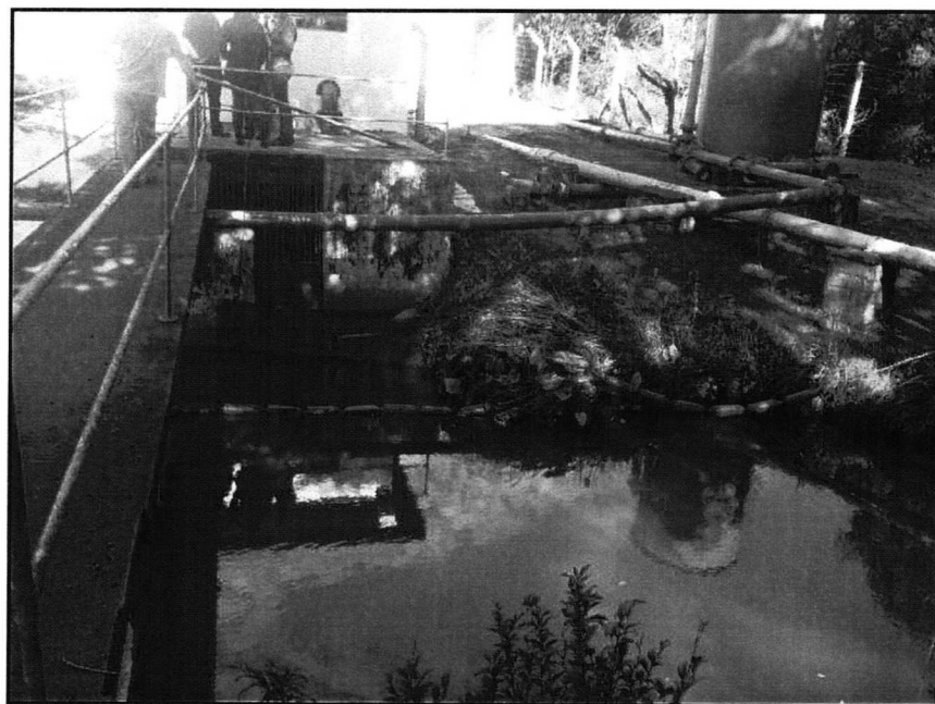
FIGURA 2.111 – LOCAL DA CAPTAÇÃO SUPERFICIAL NO RIO ERNESTO. FONTE: AMBIENTAL COSTA OESTE (2014).
