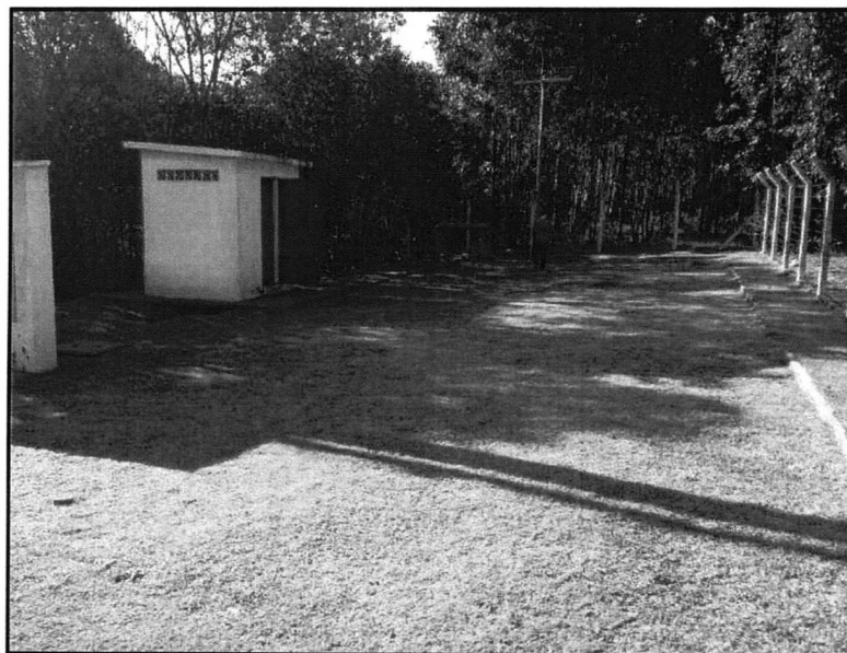
FIGURA 2.116 – ESTRUTURA DA CAPTAÇÃO SUBTERRÂNEA. FONTE: TRABALHO DE CAMPO, AMBIENTAL COSTA OESTE (2014).
