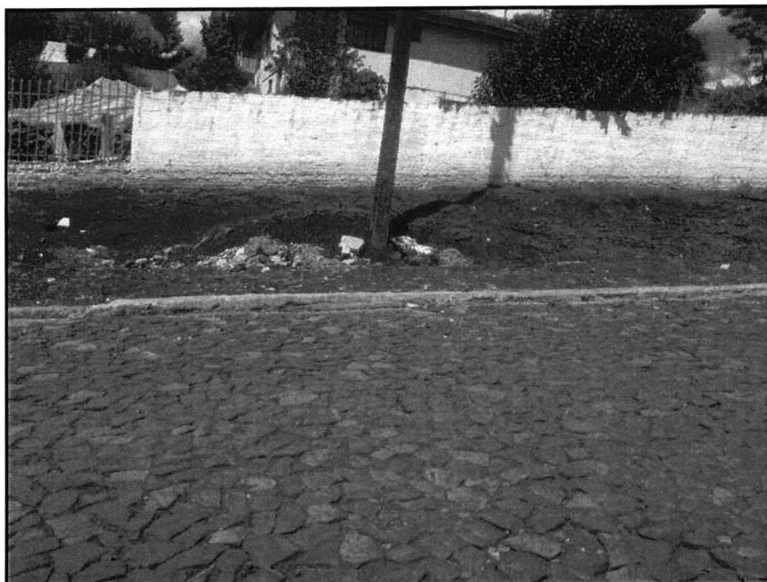
FIGURA 2.84 – ACONDICIONAMENTO DOS RCC DE FORMA ERRADA PELOS MUNICÍPIOS. FONTE – TRABALHO DE CAMPO EMPRESA AMBIENTAL COSTA OESTE (2014).
