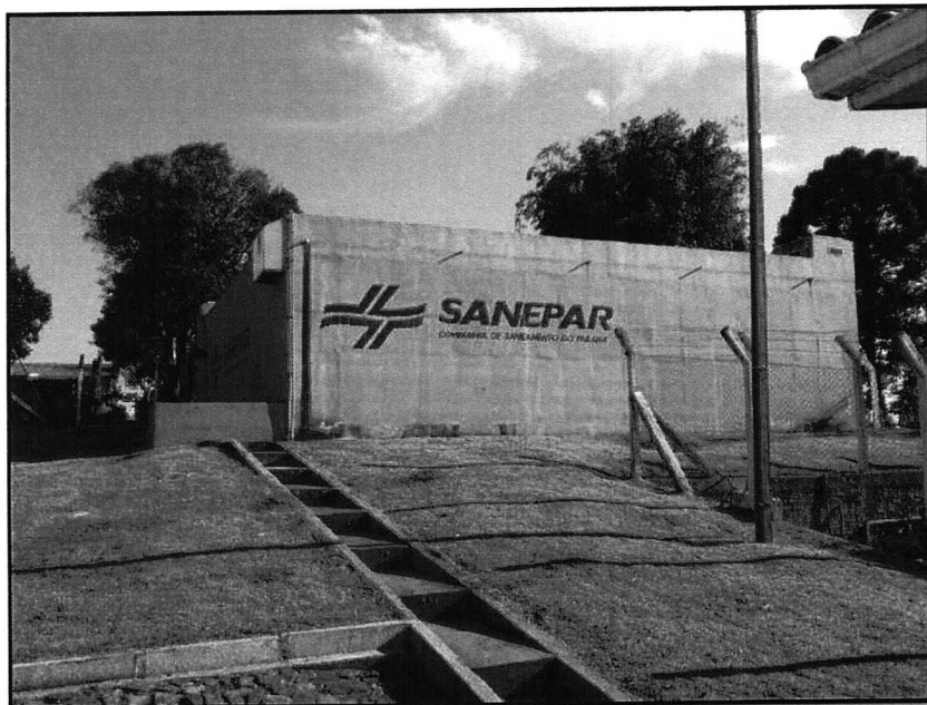
FIGURA 2.134 - RESERVATÓRIO DO PLANALTO COM CAPACIDADE DE 500 M 3 . FONTE: TRABALHO DE CAMPO, AMBIENTAL COSTA OESTE (2014).
