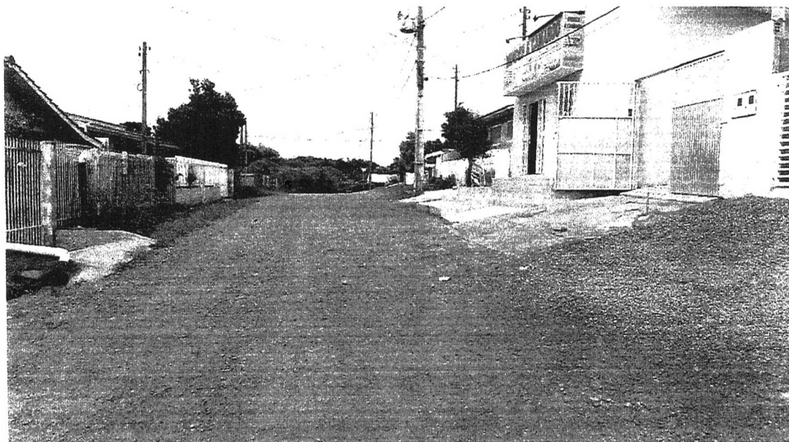
Vista do imóvel pela Travessa João Novelin.
