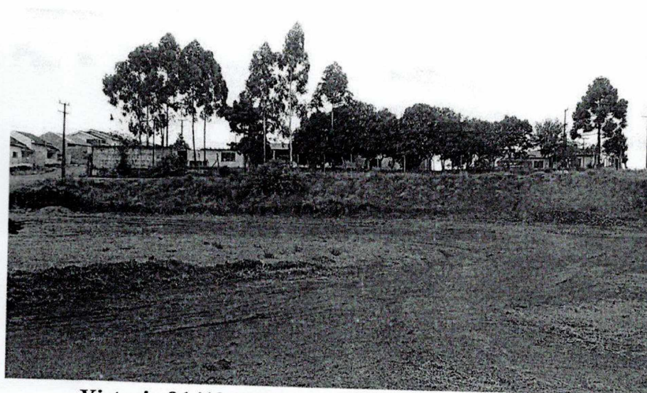
Vistoria 04/12/2017 – Quadra 099 do Setor 001 –
