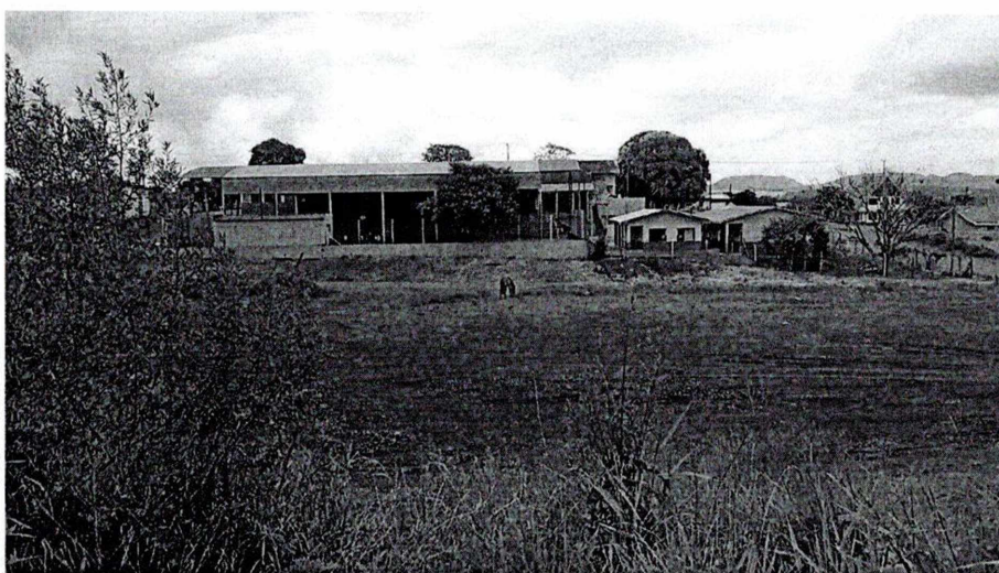
Vistoria 04/12/2017 – Quadra 099 do Setor 001 –
