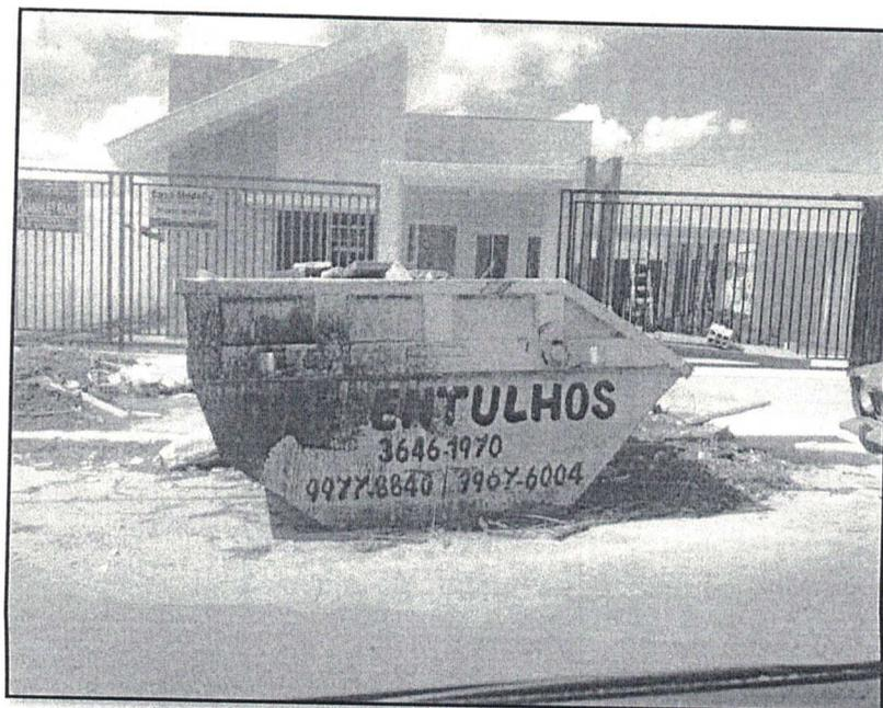
**FIGURA 2.81 – ACONDICIONAMENTO DOS RCC, QUANDO SE CONTRATA EMPRESA ESPECIALIZADA.**
