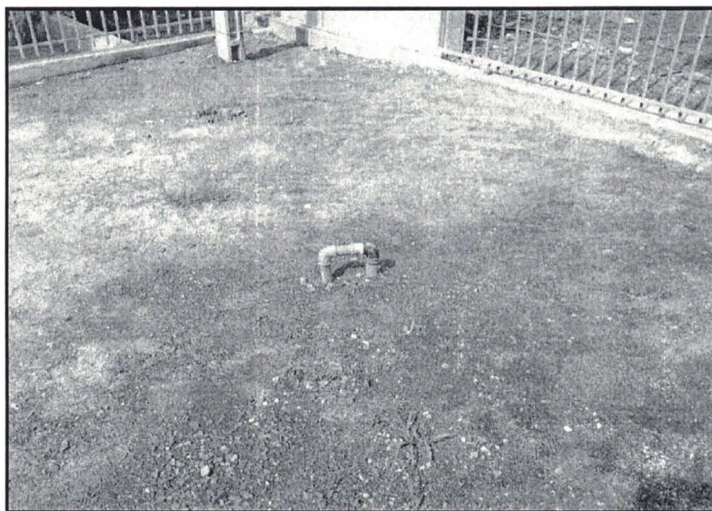
FIGURA 2.184 – SITUAÇÃO PRECÁRIA DAS INSTALAÇÕES DO POÇO NA ESCOLA DA COMUNIDADE RIO DO MEIO. FONTE: TRABALHO DE CAMPO AMBIENTAL COSTA OESTE. (2014).
