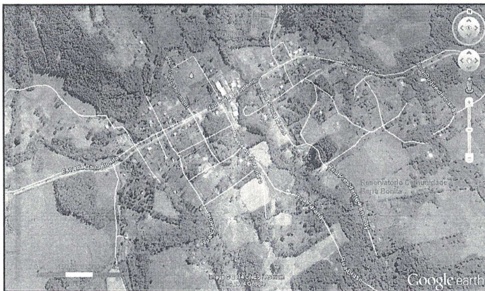
FIGURA 2.170 – LOCALIZAÇÃO DO RESERVATÓRIO EM RELAÇÃO À CAPTAÇÃO DA COMUNIDADE BARRA BONITA.
