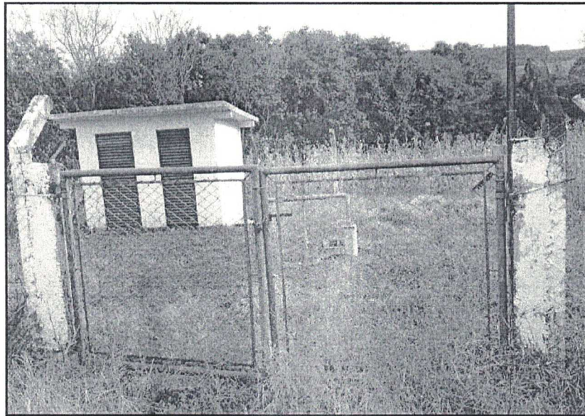
FIGURA 2.164 - SITUAÇÃO DAS INSTALAÇÕES DA CAPTAÇÃO DA COMUNIDADE BARRA BONITA.
