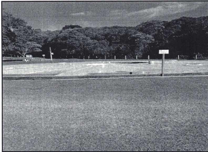
FIGURA 2.221 – RALF DA ETE PITANGA. FONTE: TRABALHO DE CAMPO, AMBIENTAL COSTA OESTE (2014).
