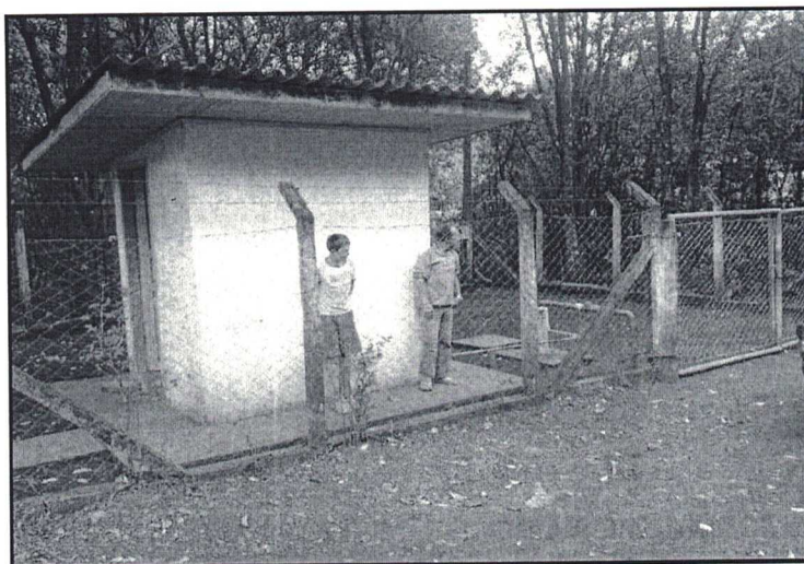
FIGURA 2.194 – INSTALAÇÕES DO POÇO NA COMUNIDADE RIO XV. FONTE: TRABALHO DE CAMPO AMBIENTAL COSTA OESTE (2014).
