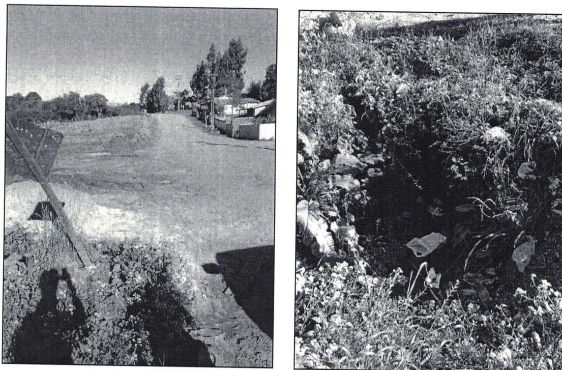
FIGURA 2.243 – VISTA DO PONTO 04. FONTE: TRABALHO DE CAMPO (2014).
