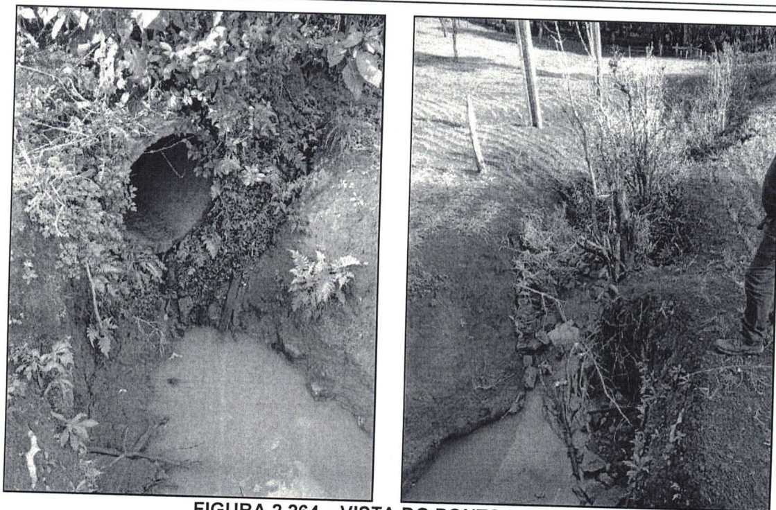
FIGURA 2.264 – VISTA DO PONTO LAN 01. FONTE: TRABALHO DE CAMPO (2014).
