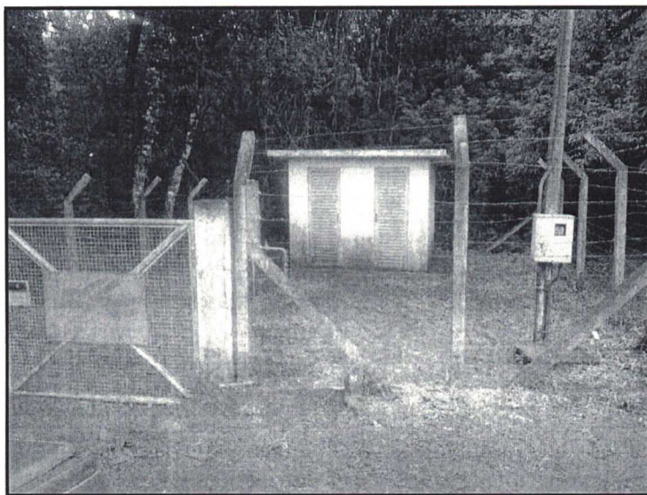
FIGURA 2.195 – INSTALAÇÕES DO POÇO NA VILA RURAL DA COMUNIDADE RIO XV. FONTE: TRABALHO DE CAMPO AMBIENTAL COSTA OESTE (2014).
